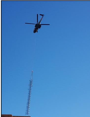
Sendeturm wurde mittels Helikopter montiert
