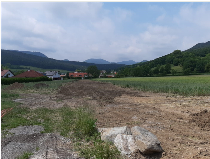
Überschwemmungsgefahr eingedämmt - 200 m Rohrleitungen wurden verlegt
