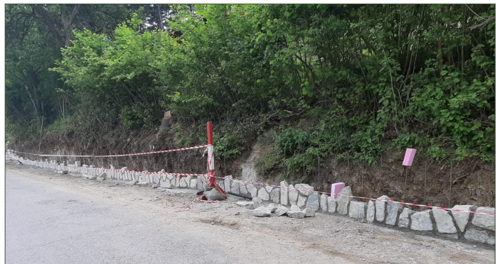
Stützmauer zwischen Oberhöflein und Zweiersdorf , die Arbeiten gehen voran
