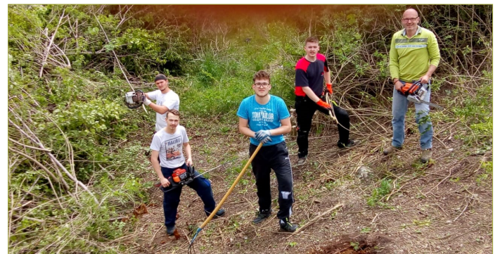
Rodungsarbeiten mit der Jugend - der Beachvolleyballplatz nimmt Gestalt an
