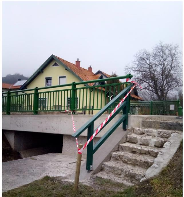
Im Zuge der Brückenerneuerung wurde der Stiegenabgang mit einem Geländer gesichert
