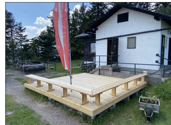
Also haben wir vom Holzwerk SEIER in Wr. Neustadt gehobeltes Lärchenholz angeschafft, Balkenlänge 5 Meter, Querschnitt 200/5 mm, und in bewährter Teamarbeit nach Errichtung eines soliden Unterbaus am alten Standort montiert.
