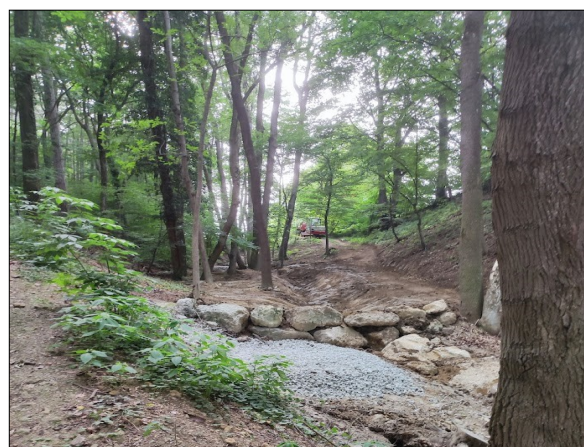
Rückhaltebecken aus Steinschichtung
