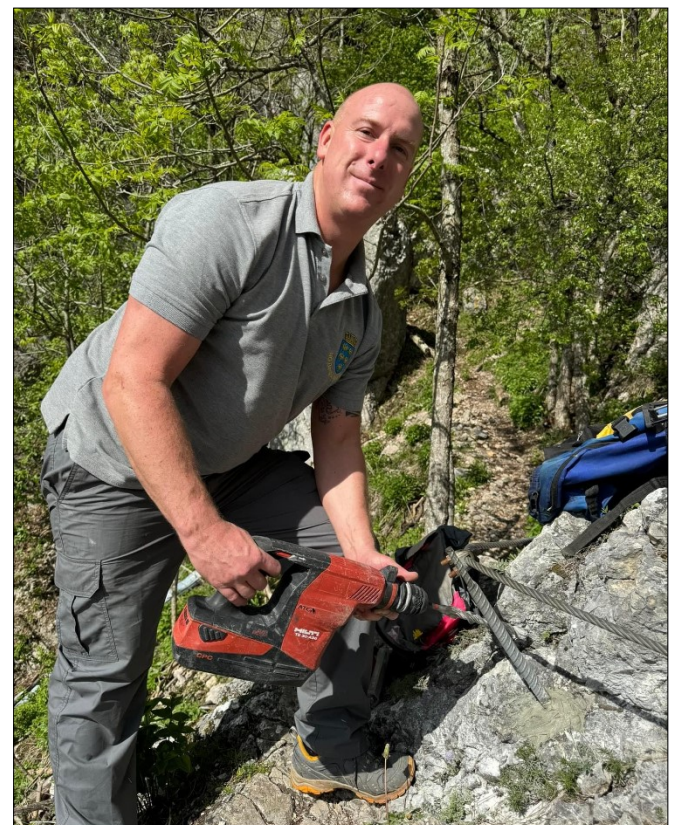
Die Drahtseilstütze konnte wieder befestigt werden.
