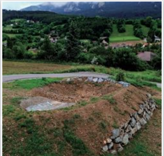
Rückhaltebecken am Eisenbahnweg
